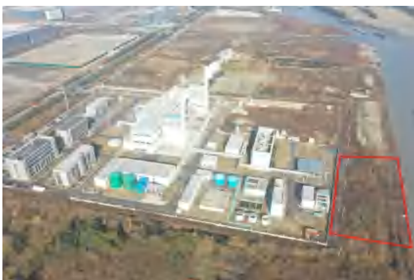
取水设施区临时占地恢复情况
