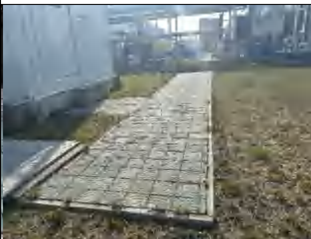
厂区透水铺装（2023年12月）
