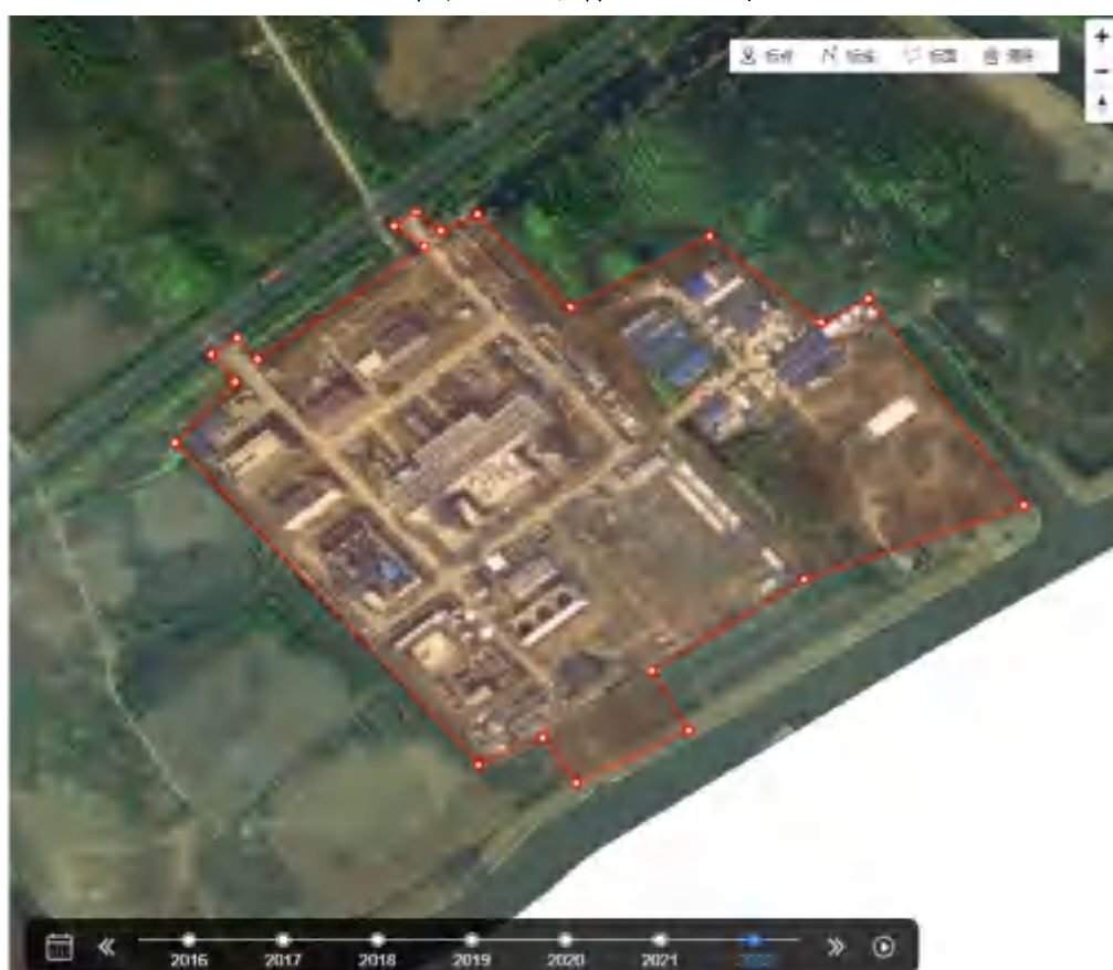
施工中项目区影像（2022年）
