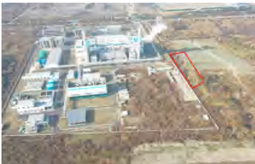
施工生产生活区临时占地恢复情况
