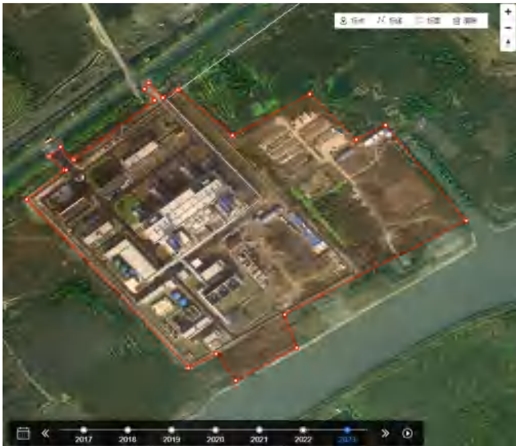
施工中项目区影像（2023 年）
