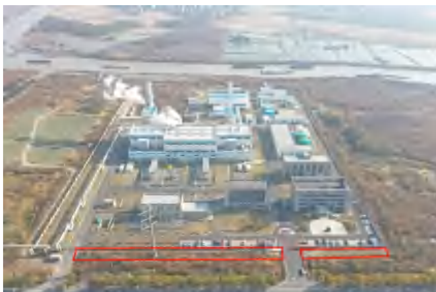
厂区临时占地恢复情况
