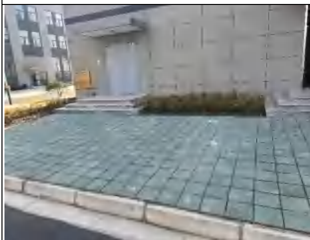
厂区透水铺装（2023年12月）
