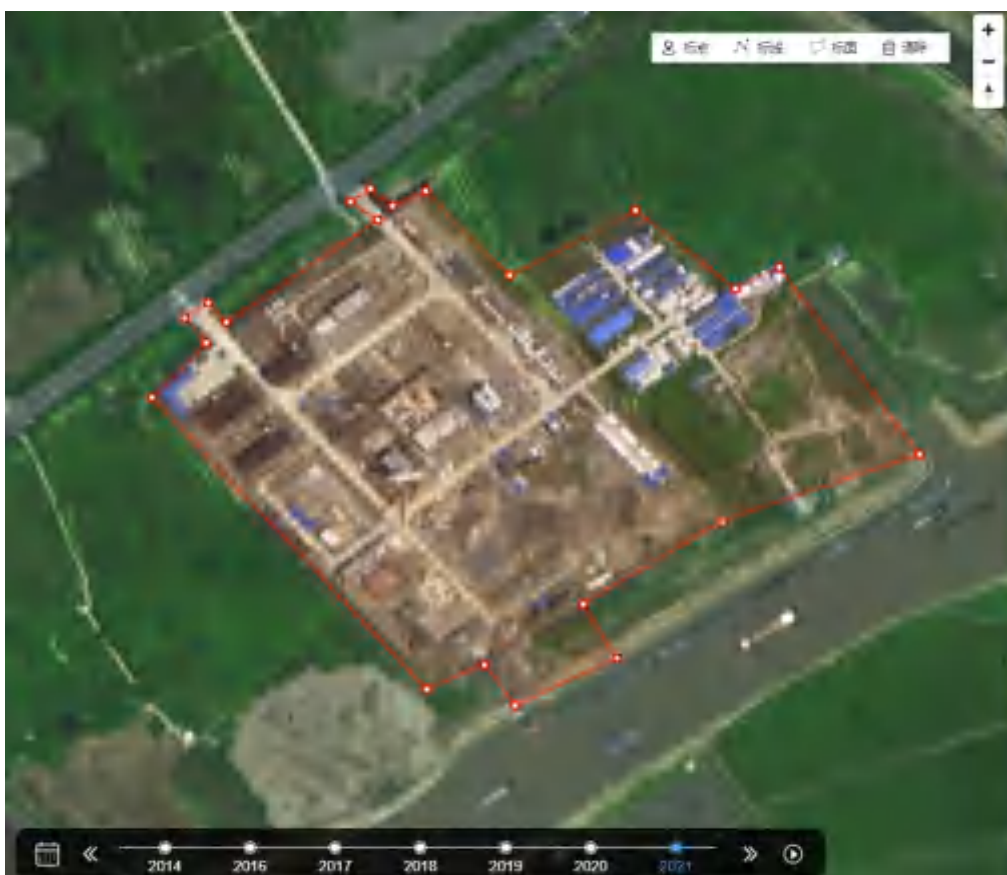
施工中项目区影像（2021年）
